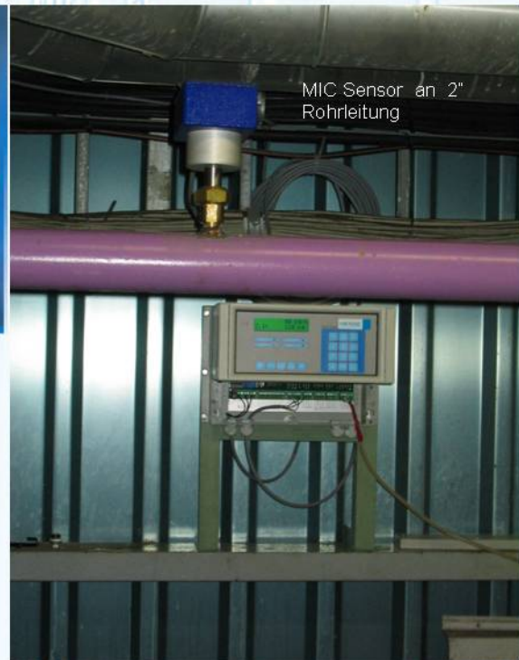
MIC—Sensor mit abnehmbaren Hohlleiter
